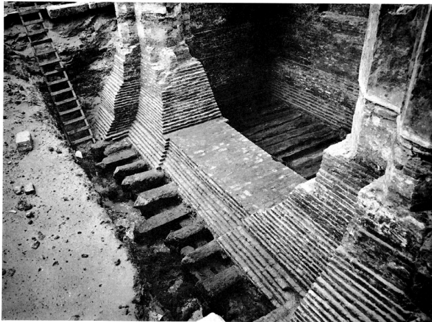
'Binnenaanzicht van de derde zuiderkapel, gerekend van het westen af, met de tot buiten de gevel uitstekende vlotbalken. Onder de bouwmuuren rusten deze op randbalken van het roosterwerk, waarbinnen de palen geslagen zijn...'
